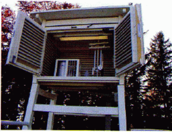
Abb. 2 Wetterhütte mit Geräten
